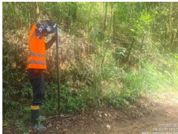
Foto 39 – Instalação placas de sinalização 2 (Data: 19/11/2022).
